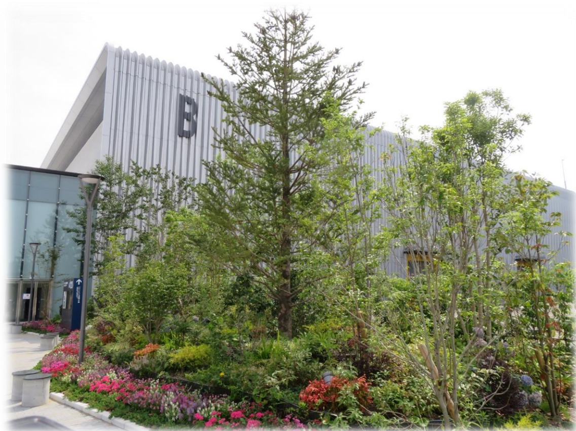
マリンメッセ福岡B館 植栽工事
